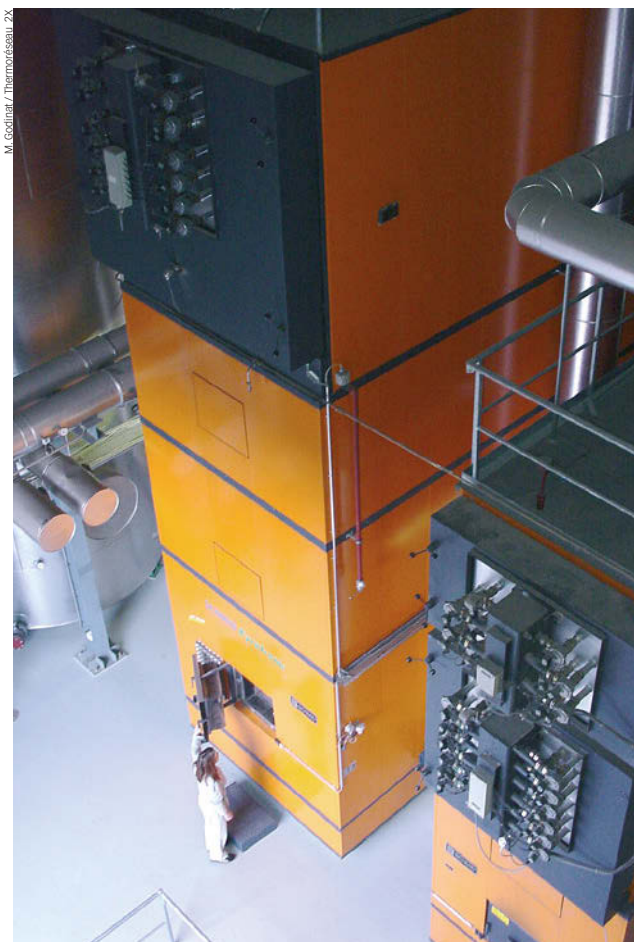
En haut à gauche : pose d'une section du réseau de chauffage à distance de Porrentruy ; ci-dessus : la chaudière correspondante
