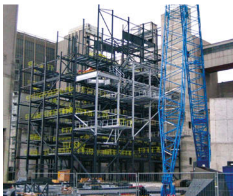
A Vienne, la valse des échafaudages a commencé
