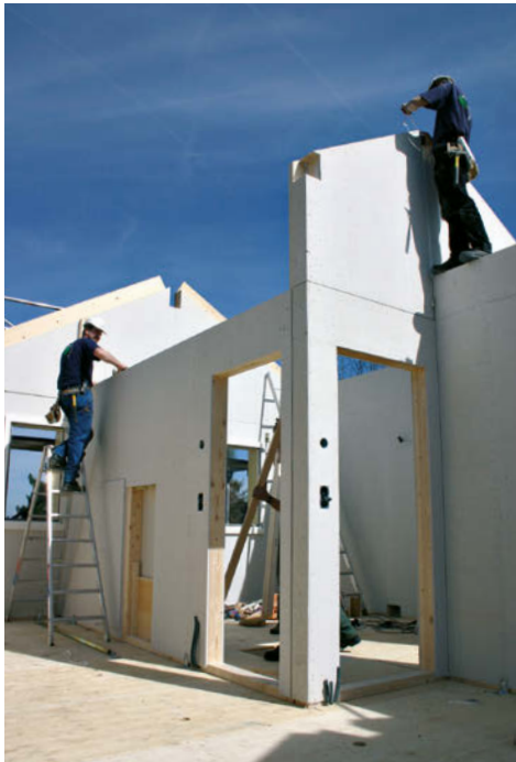
Construction d'une maison unifamiliale en bois
