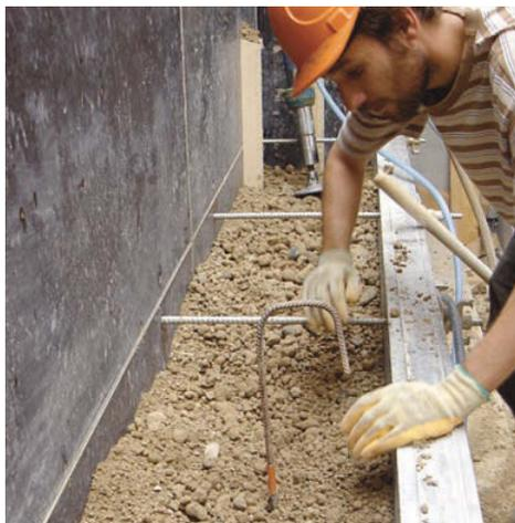
Mur de terre, à l'intérieur d'un coffrage
