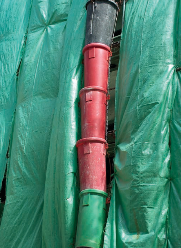
Déchets de construction en quantités colossales
